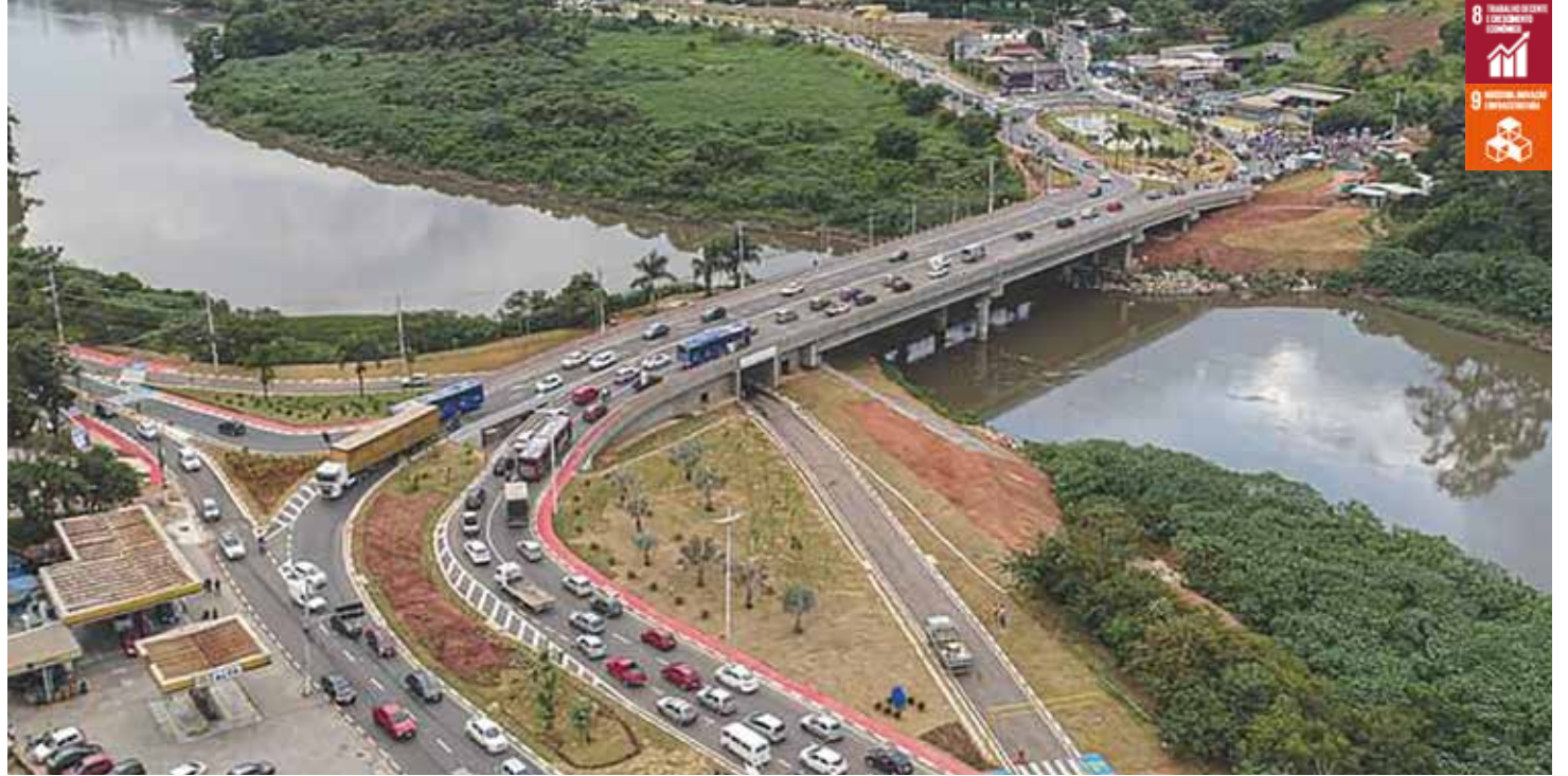
A nova ponte tem uma passagem de nível que faz a ligação direta entre as estradas Bela Vista e Tenente Marques
